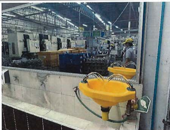
ภาพที่ 33 ฝักบัวและอ่างล้างตา
