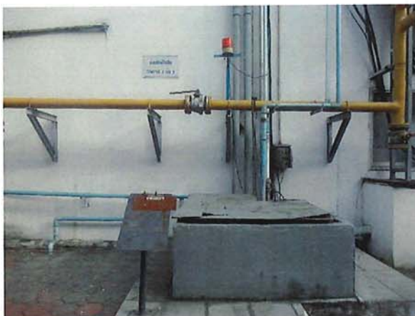
ภาพที่ 11 บ่อรวบรวมน้ำทิ้งจากกระบวนการผลิต
