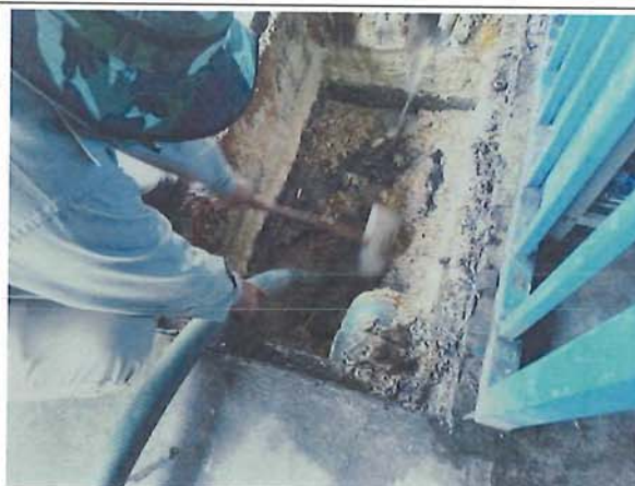
ภาพที่ 18 เจ้าหน้าที่ดูแล ทำความสะอาดถังดักไขมัน
