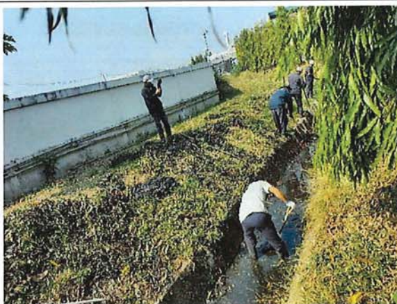
ภาพที่ 23 เจ้าหน้าที่ทำความสะอาดระบบระบายน้ำฝน
